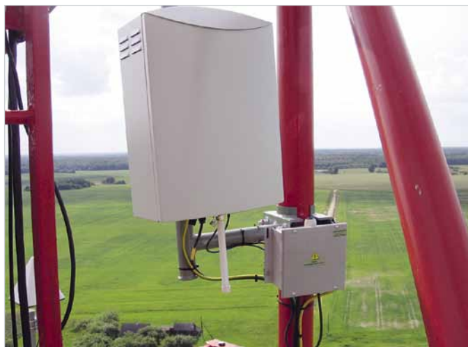
BILD 2 In diesem Beispiel ist ein Monitoring-System R&S®UMS100 am Mast eines Mobilfunkbetreibers montiert.
