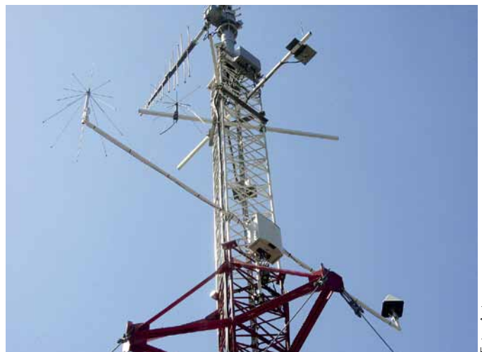
BILD 1 In Hauptstationen integrierte Monitoring-Systeme R&S®UMS100 werden am gemeinsamen Antennenmast unterhalb der Peil- und Monitoring-Antennen und des Rotors befestigt.
